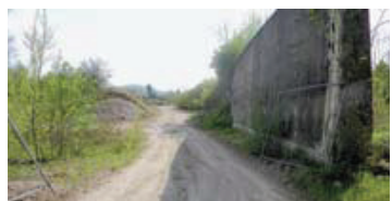
6 - Campagna Adorna/Valera. Il comparto Valera, ex zona per deposito idrocarburi
