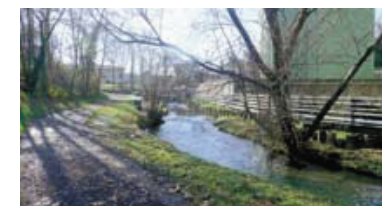
4 - Stazione. Il fiume passa accanto ai serbatoi di benzina
