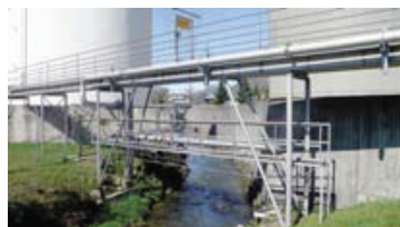
5 - Cercera. Il fiume costretto tra due muri di cemento a Cercera
