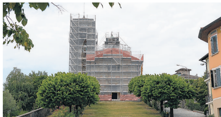
Intervento di recupero e risanamento
