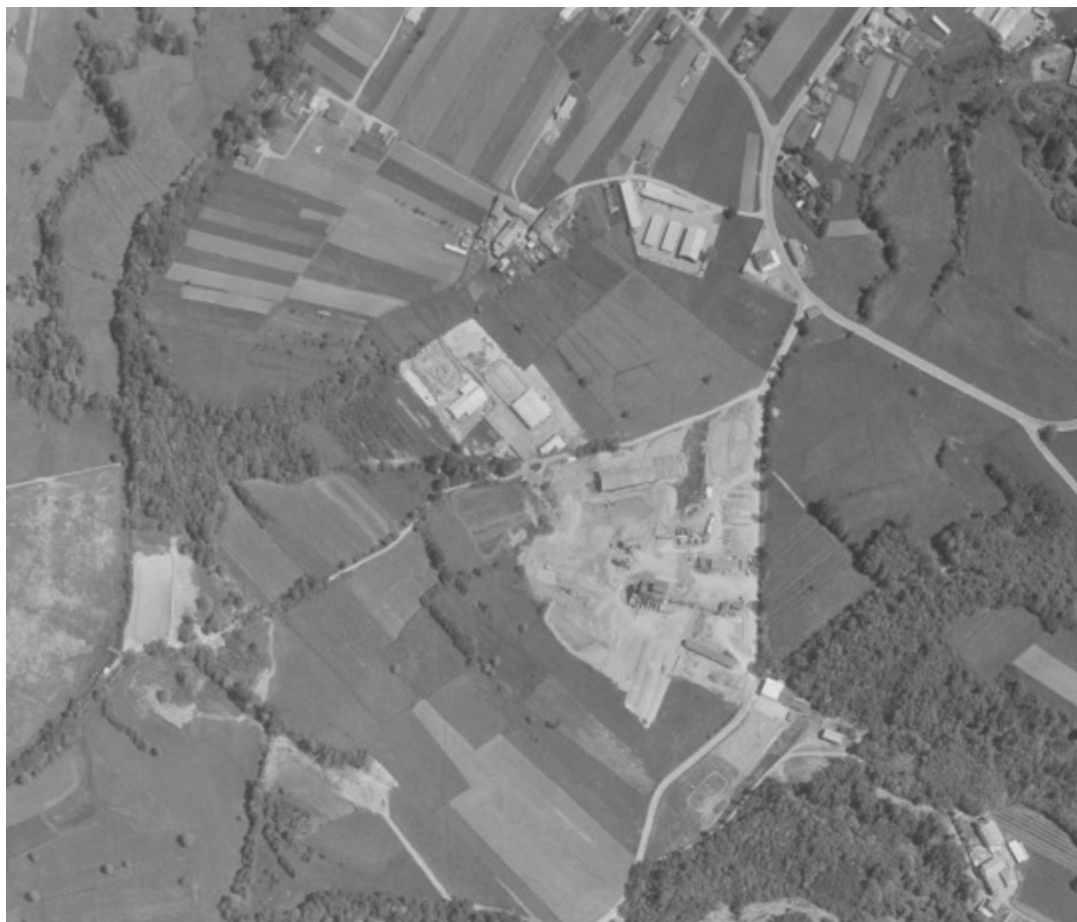
1966 – Terreni agricoli, “Meandri del Laveggio”, piazza di lavoro per cantiere autostradale, vasca per il lavaggio degli inerti.
